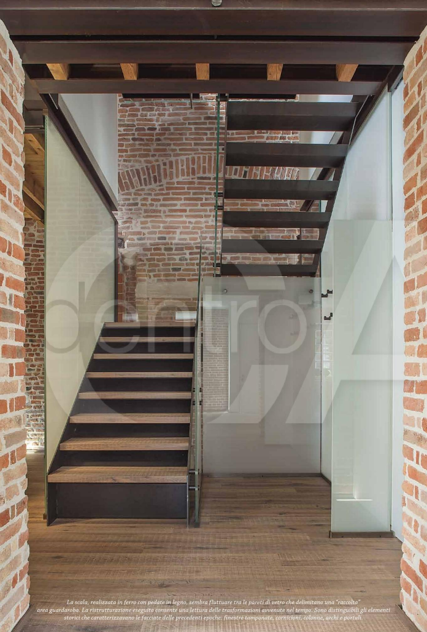
*La scala, realizzata in ferro con pedate in legno, sembra fluttuare tra le pareti di vetro che delimitano una "raccolta" area guardaroba. La ristrutturazione eseguita consente una lettura delle trasformazioni avvenute nel tempo. Sono distinguibili gli elementi storici che caratterizzavano le facciate delle precedenti epoche: finestre tamponate, cornicioni, colonne, archi e portali.*
