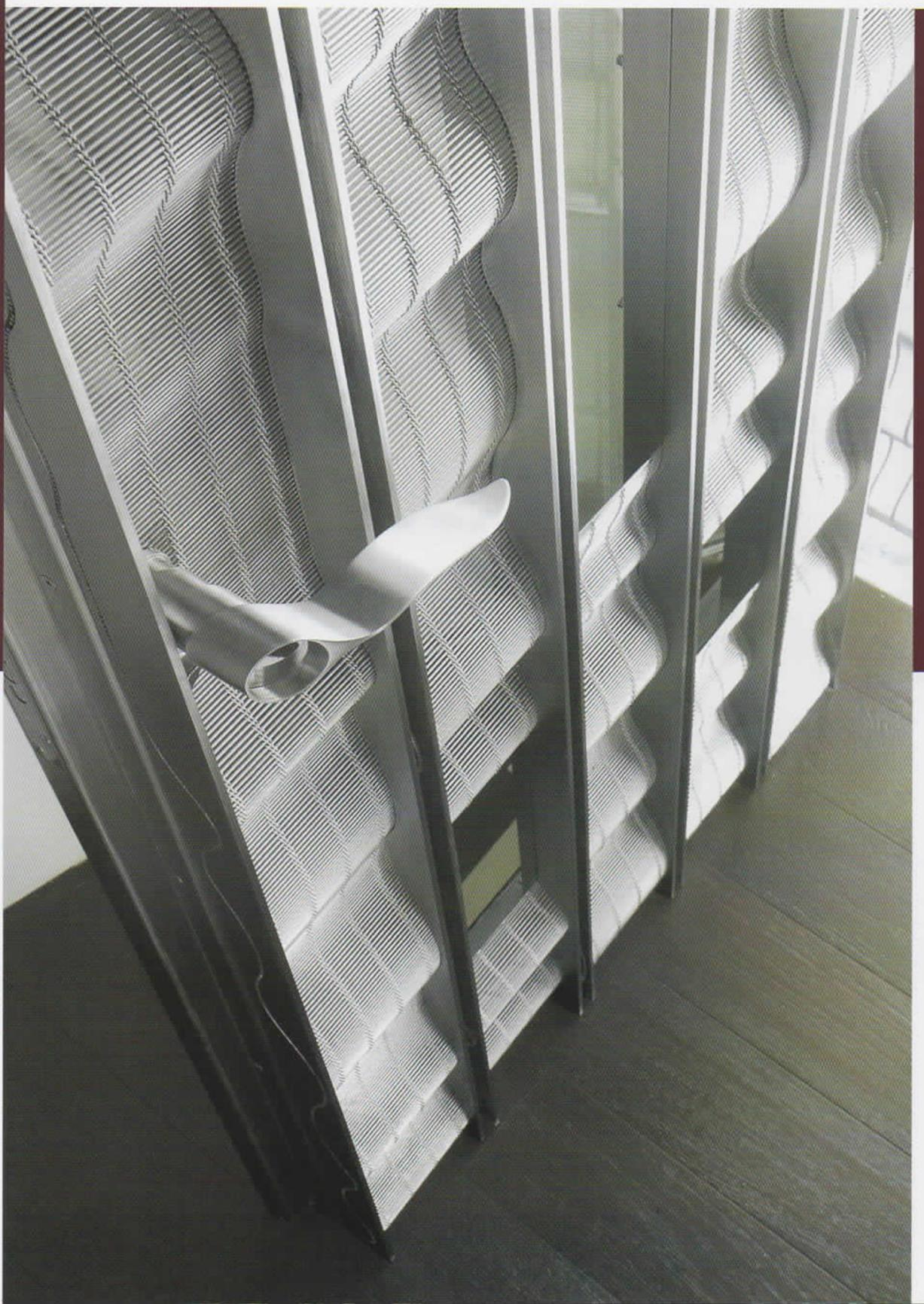
materiale acciaio inox - rete a maglia sciolta - vetro blindato >> materiale: stainless steel - free flowing mesh - armoured glass
